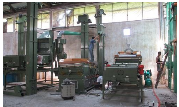
選別機械を新設中
